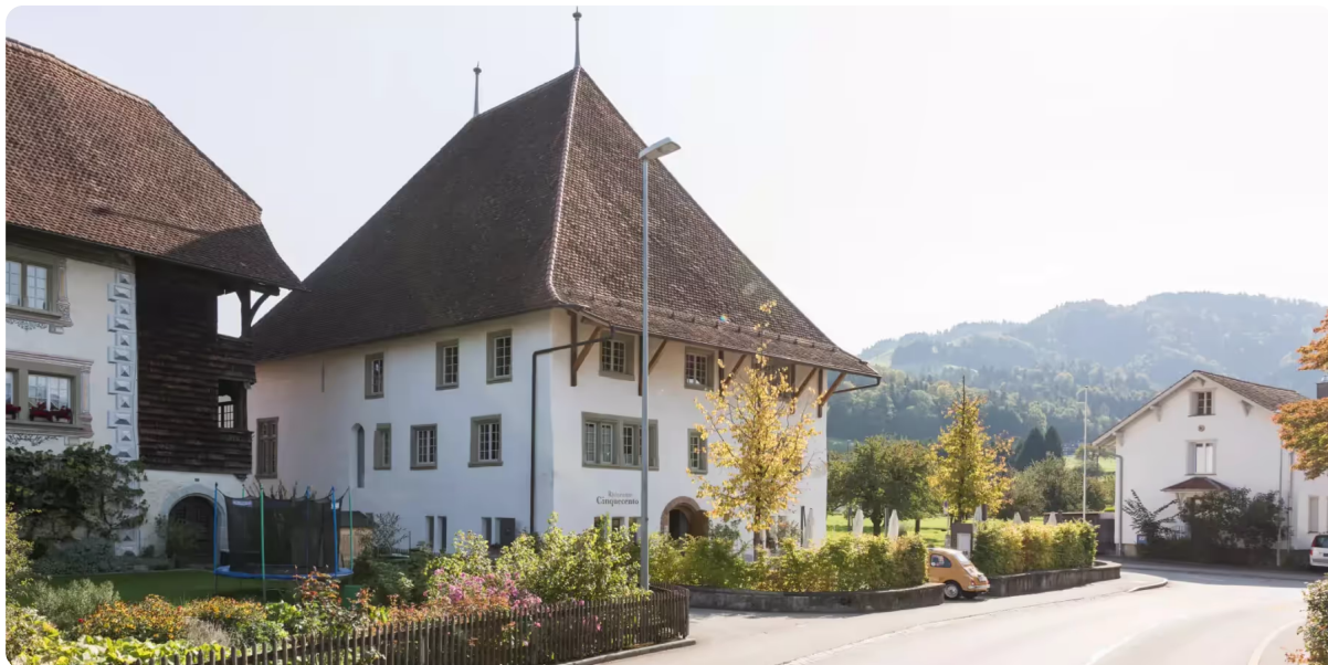
In den Jahren 2007/2008 wurde das Höchhus umfassend saniert. - Gemeinde Steffisburg
